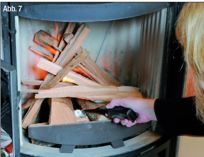
Achten Sie darauf, dass sowohl die Holzscheite als auch das Anzündholz aufgelockert liegen, damit genügend Verbrennungsluft an des Brennholz gelangt.
