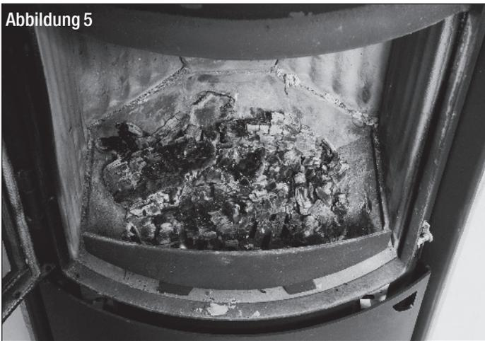
Je nach Holzgüte, Schornsteinzug und Witterung dauert diese Verbrennungsphase unterschiedlich lange. Legen Sie jetzt zwei weitere Holzscheite parallel zur Feuerraumscheibe auf und verschließen die Feuerraumtür (Abb. 6).
