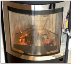
Sekundärluft: Komplett geöffnet ("MAX")
