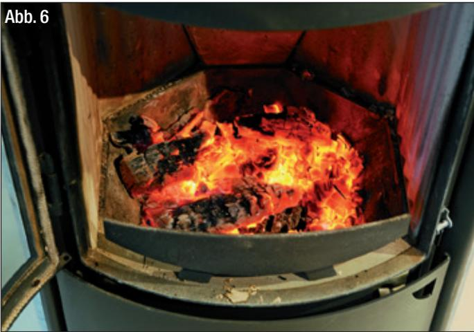
Je nach Holzgüte, Schornsteinzug und Witterung dauert diese Verbrennungsphase unterschiedlich lange.
