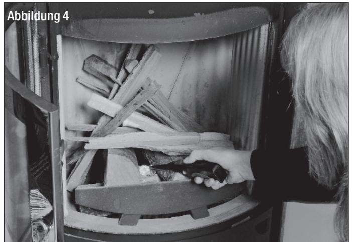
Je nach Holzgüte, Schornsteinzug und Witterung dauert diese Verbrennungsphase unterschiedlich lange. Legen Sie jetzt zwei weitere Holzsplitter parallel zur Feuerraumsplitter auf und verschließen Sie die Feuerraumtür (Abb. 6).
