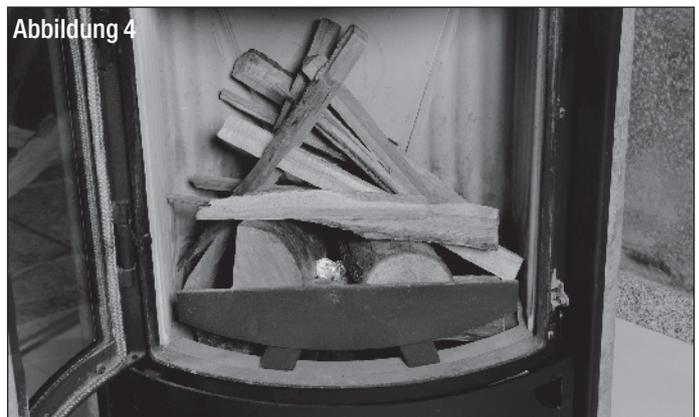
Lassen Sie diese Holzauflage mit geöffnetem Brennstoffwähler herunterbrennen, bis eine Grundglut vorhanden ist (Abb. 6). Je nach Holzgüte, Schornsteinzug und Witterung dauert diese Verbrennungsphase unterschiedlich lange.
